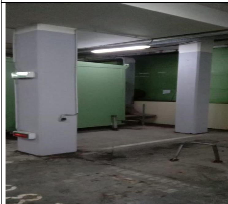
Кор.1-2, эт.-1 Заглубленный проезд Окраска колонн -окраска колонн
