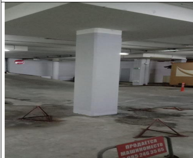
Кор.1-2, эт.-1 Заглубленный проезд Окраска колонн -окраска колонн
