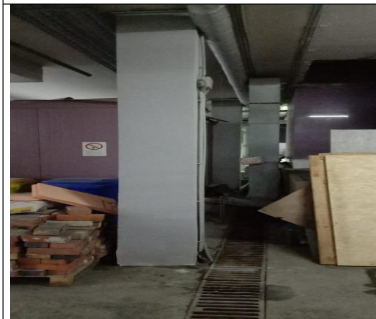
Кор.4, эт.-1 Заглубленный проезд Окраска колонн -окраска колонн
