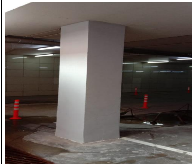
Кор.3, эт.-1 Заглубленный проезд Окраска колонн -окраска колонн
