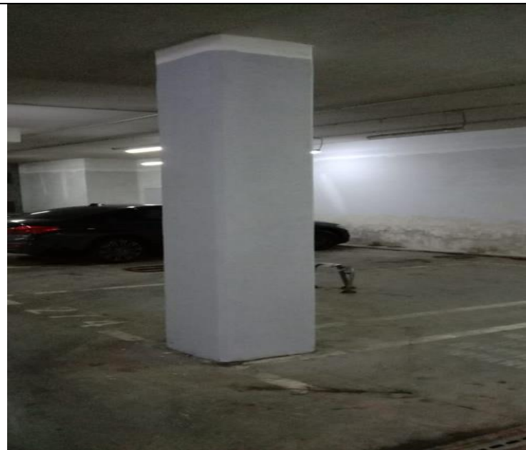
Кор.1-2, эт.-1 Заглубленный проезд Окраска колонн -окраска колонн
