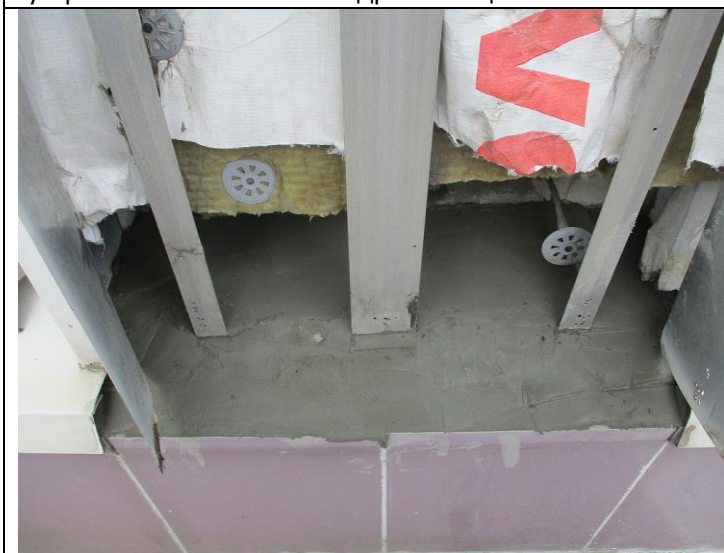
Кор.5, Сек.5, эт.1 Территория Устройство обмазочной гидроизоляции -подготовка поверхности -устройство обмазочной гидроизоляции
