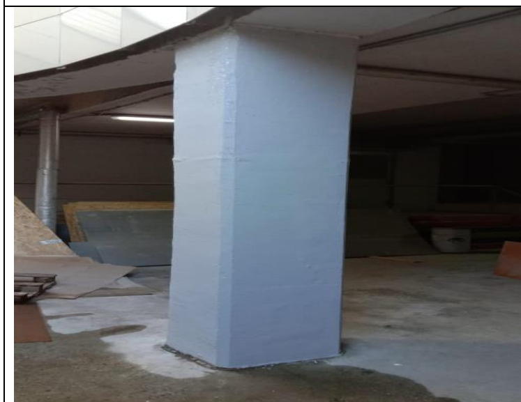
Кор.4, эт.-1 Заглубленный проезд Окраска колонн -окраска колонн
