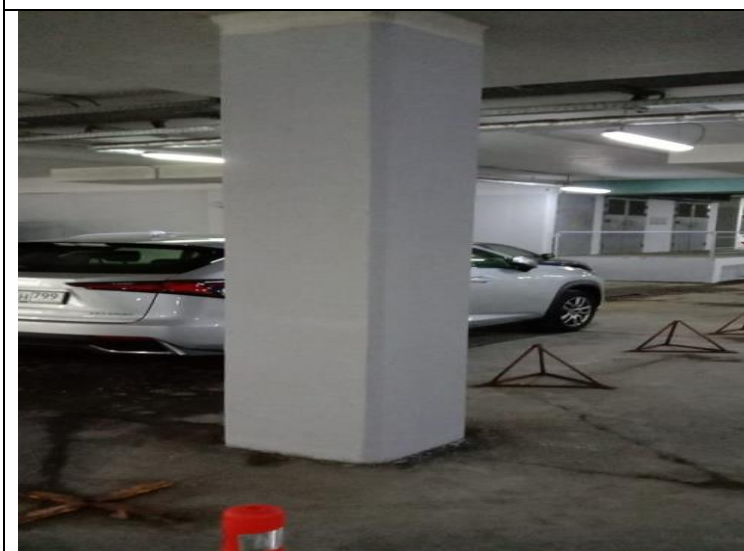
Кор.1-2, эт.-1 Заглубленный проезд Окраска колонн -окраска колонн
