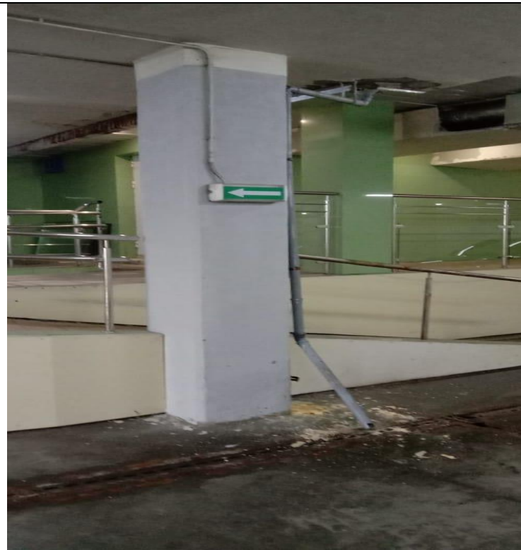
Кор.1-2, эт.-1 Заглубленный проезд Окраска колонн -окраска колонн
